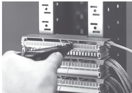
Connettere il cavo in base al codice dei colori mediante l'utensile di cablaggio VS e usando il contatto [c] per il cabaggio del filo di accompagnamento.
