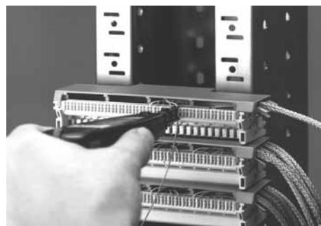
Connecter le câble selon le code couleur à l'aide de l'outil de connexion VS, le contact [c] servant au raccordement du fil de continuité.
