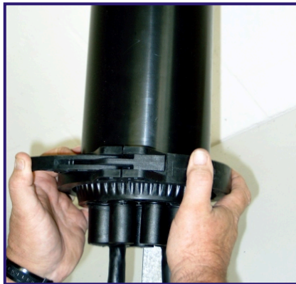
23 Replace swing clamp.
