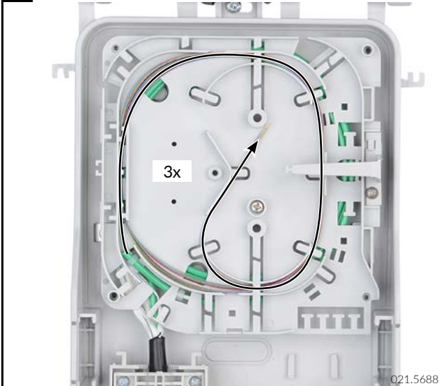
D5 Fiber routing / Faserführung
